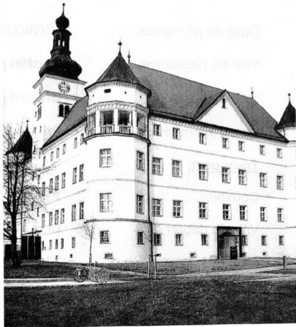
Château de Hartheim dans son état actuel.
