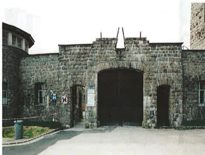
Entrée des garages SS
