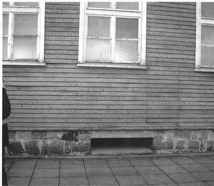
Fenêtres des cuisines
